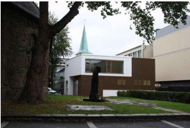
Das neue Gemeindehaus mit Gemeindebüro (Pariser Str. 4-6), zwischen Pauluskirche und Modehaus Baltz
